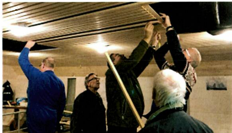
Werken aan plafond
